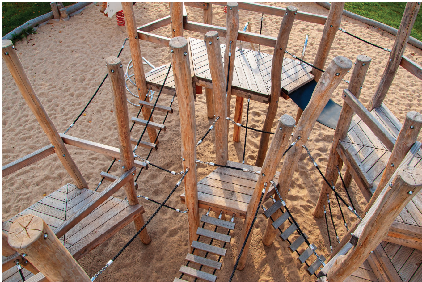
Pfosten aus Robinie, Podeste und Unterkonstruktion aus Douglasie
